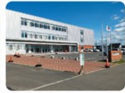
名寄南小学校 (平成27年度完成)
