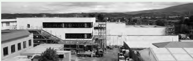
▲新図書館工事のようす (外壁が現れました)
