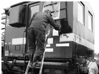
▲毎年6月に実施しているキマロキの塗装作業の様子
