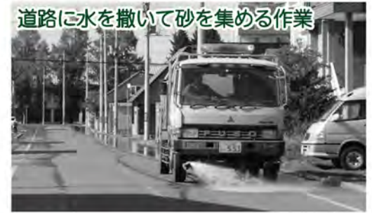
道路に水を撒いて砂を集める作業
