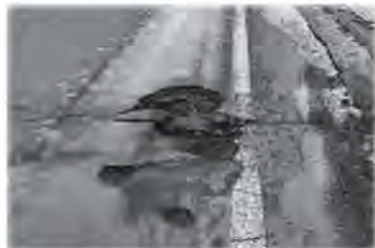
▲雪解け後の道路の損傷
