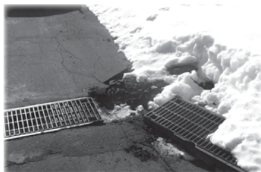
▲除雪作業が原因と考えられる道路施設の損傷
