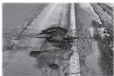
▲雪解け後の道路の損傷
