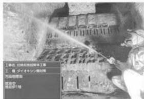
▲機器類のダイオキシン類除去作業のようす
