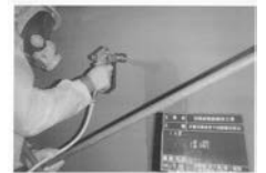
▲アスベスト除去前の湿潤作業のようす
