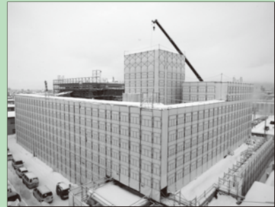
現在の工事状況（平成26年1月現在）
