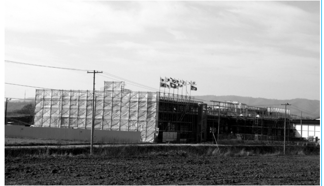
建設中の農畜産物処理加工施設
