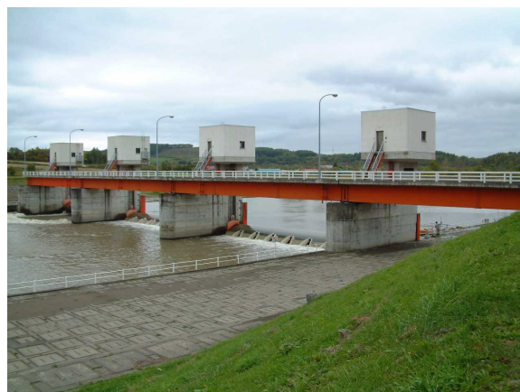
真勲別頭首工
