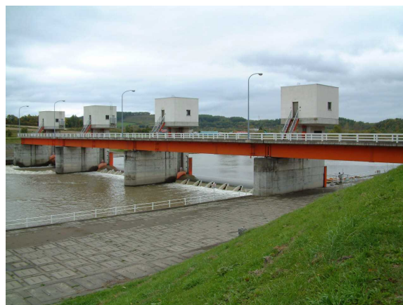
真勲別頭首工
