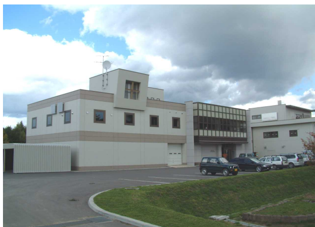
緑丘浄水場・水質検査施設
