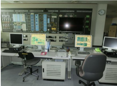
①操作管理室
