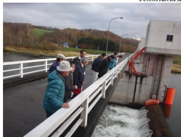
真敷別頭首工
