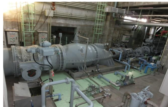
H27年度 雨水ポンプ分解整備修繕 金9,396,000円
