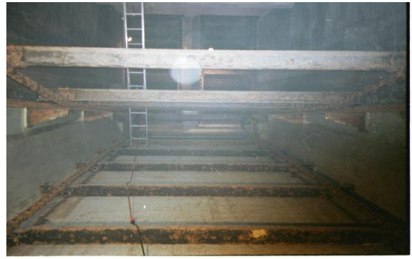
雨水沈砂掻寄機(H28年度更新予定)
