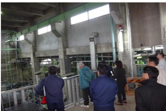
(S52, 55、H4設置)、吐出量 200t/分/台
