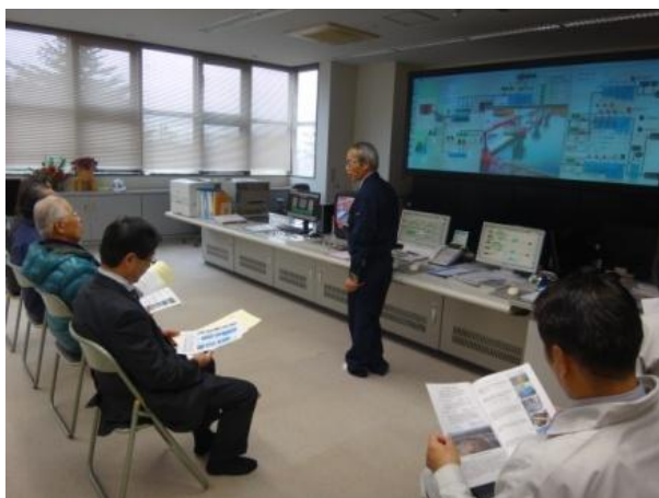
事務室（中央操作室）
