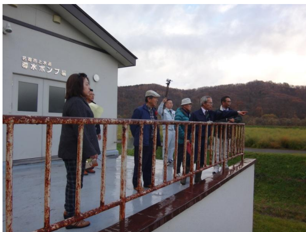
導水ポンプ場屋外
