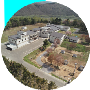
空から見た緑丘浄水場
