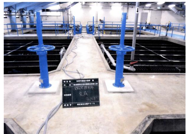
1 拡沈殿池仕切弁開閉台取替工事
