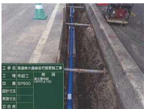
(老朽管敷設工)
