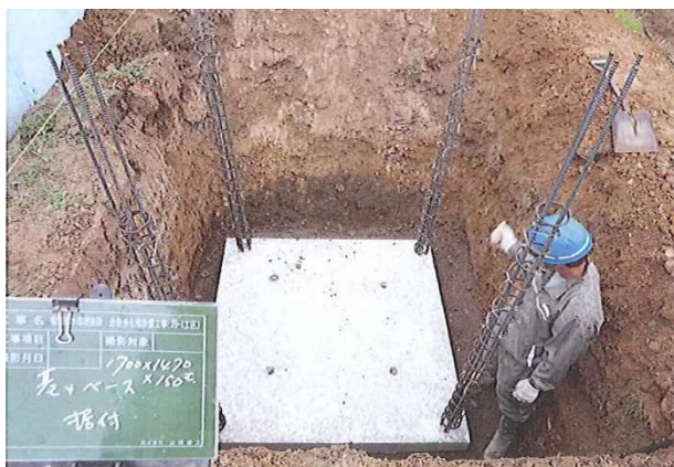
(施工写真①・底版据付)
