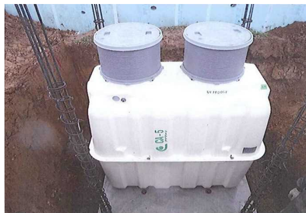
(施工写真②・浄化槽設置)
