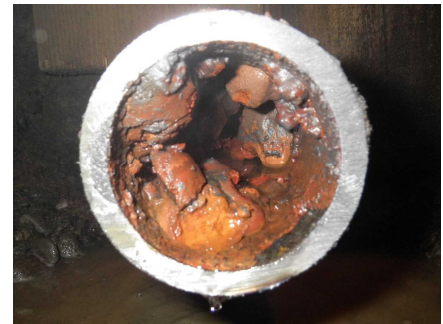
※昭和36年布設の鑄鉄管(H25更新済)
