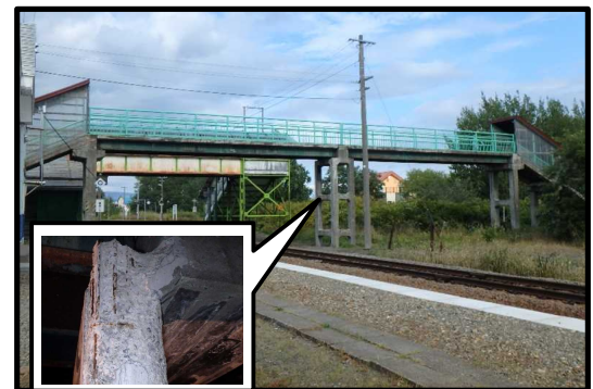
風連駅跨線橋（橋梁長寿命化事業）
